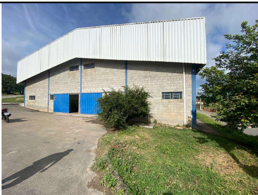
Quadra Poliesportiva - Distrito Bituri, Jeceaba/MG
